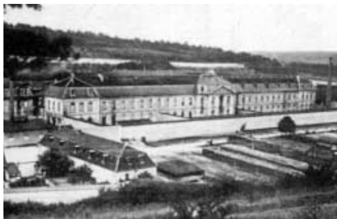
Clairvaux - Vue générale de la Maison centrale, ancien monastère fondé en 1114 par Saint Bernard
